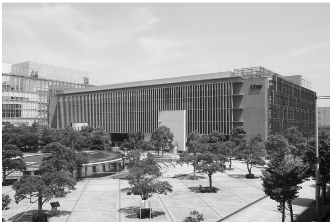
写真-1 東京都立産業技術研究センター新本部の外観
